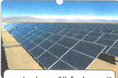
٣ - محطة الكريما في الجيزة لتوليد الكهرباء من الطاقة الشمسية.
